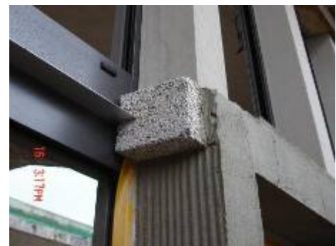
Bauteil auf Portal montiert
