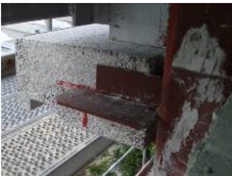
Bauteil seitlich geschlitzt, montiert auf Stahlbau - Konsolen
