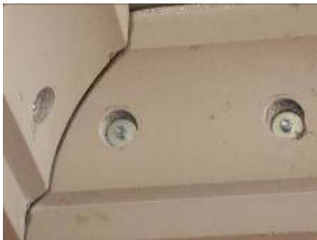
Verankerung mittels A2 Gewindestangen, vollflächig verklebt
