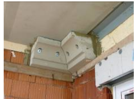
Führungsleiste als Montagehilfe
