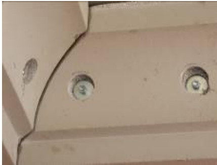
Verankerung mittels A2 Gewindestangen verklebt
