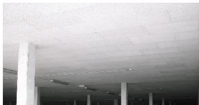
Bei Decken und Wänden aus Ortbeton wird die Prottelith Dämmplatte ohne zusätzliche Befestigungssysteme in die Schalung eingelegt und mitbetoniert.
