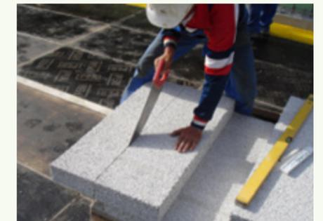
Alle 3 Reihen und 3 Platten ausrichten und Fugen press stoßen. Dazu empfehlen wir leichte Schläge unter Einsatz einer Druckverteilung.
