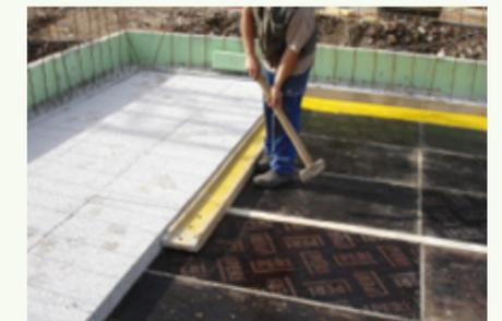
Die Bewehrung wird auf die Dämmplatten aufgelegt. Drunterleisten für Dämmstoffe verwenden (Flache Seite nach unten).
