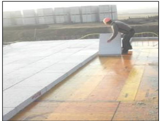
Prottelith Dämmplatte zum mitbetonieren, ohne zusätzlicher Montagehilfsmittel einzulegen
