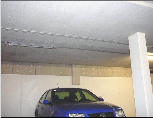
Prottelith Dämmplatte mitbetoniert
